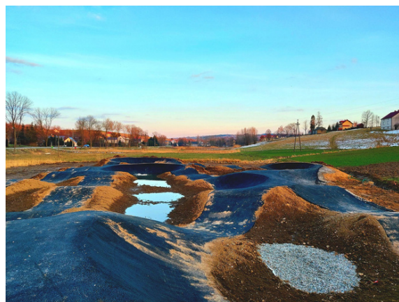
Pumptrack w trakcie realizacji, fot. K. Rapała
