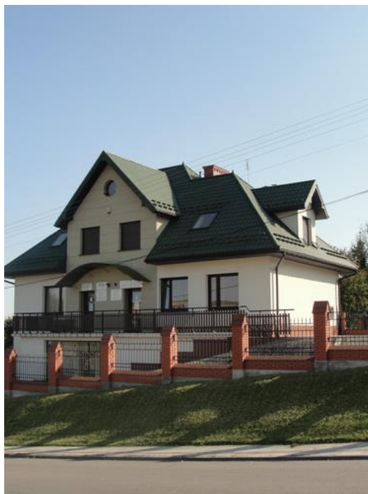
Nowy budynek ośrodka zdrowia
